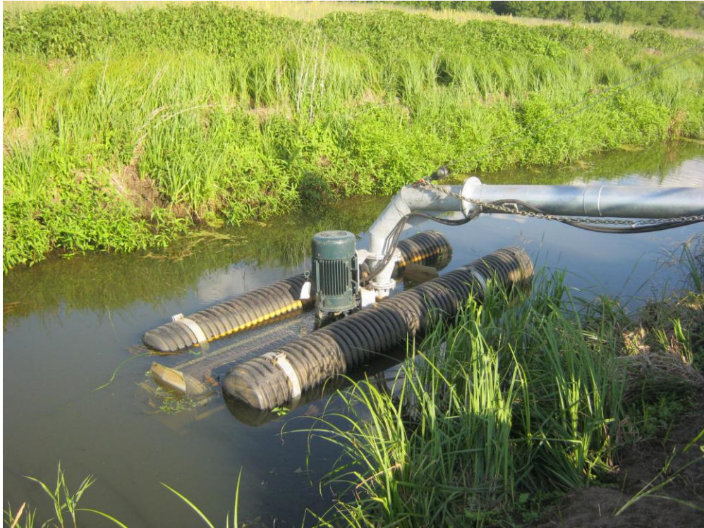
Рис. 4 Загальний вигляд водозабірної пристрою
