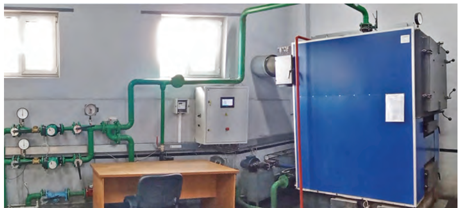
Рисунок 6 – Твердопаливна котельня інституту, яка працює на січці міскантусу
