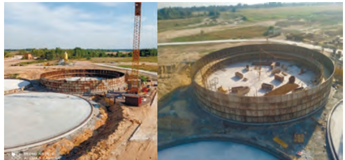
Рис. 7 – Фото з будівельного майданчика в с. Чорний Ріг, 2021 рік
