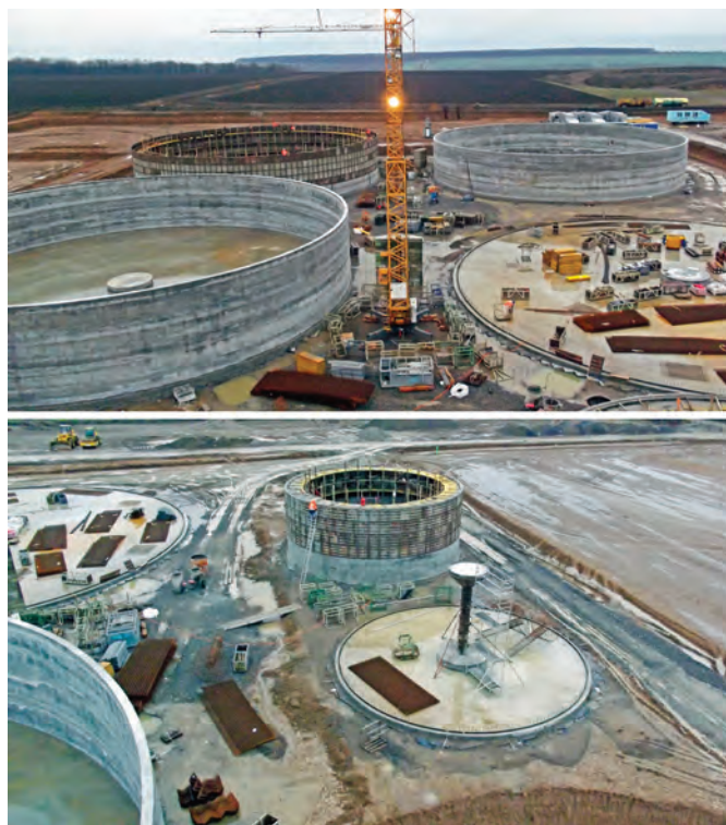
Рис. 5 - Будівництво біогазової станції концерну «МХП» м. Ладизин, Вінницької обл.
