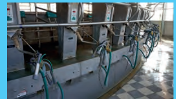
Загальний вигляд місць для доїння
