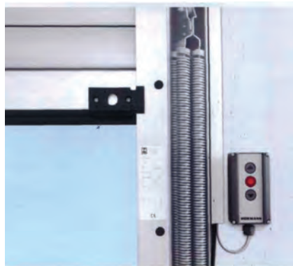
Рис. 4 – Блок керування приводом рулонних воріт
